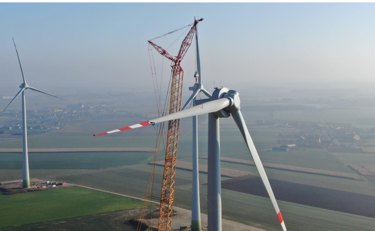
Budowa nowych turbin 4x 4MW
