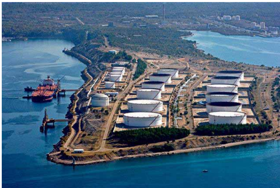
Rys. 8. Terminal naftowy w Omisalj Źródło: JANAF
